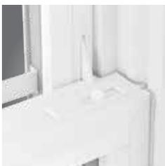
Loquets à bascule emboîtants et butées d'aération du châssis.
