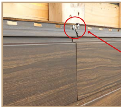
Joint avec deux vis
