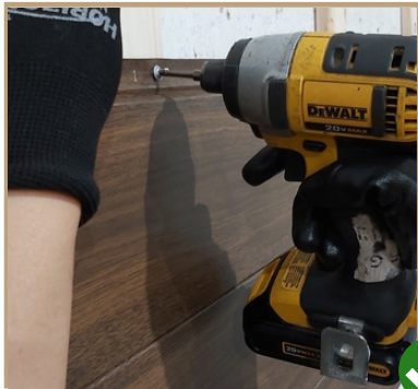
Vissage en 90 degrés
