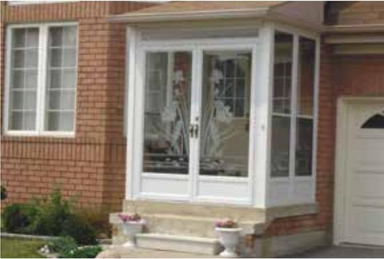
Les porches Gentek sont fabriqués à partir de panneaux d'enveloppe faits sur mesure qui sont spécifiquement conçus pour s'insérer dans les ouvertures existantes. Chaque panneau est fait de traverses d'enveloppe en aluminium de 1-3/4" et est assemblé sur les lieux à l'aide de rails à glisser pour les ouvertures égales et inégales. Les contre-portes sont ensuite installées pour compléter l'enveloppe, vous permettant de profiter de la beauté, de la polyvalence et du confort toute l'année.
