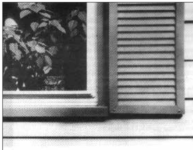
**1. Couverture de seuil** – Formez la moulure aux dimensions du seuil en bois qui doit être recouvert. Pour le solin, coupez et pliez les languettes vers le haut au niveau du jambage et des extrémités du seuil comme illustré. Installez avec des clous à moulure à petite tête et/ou un adhésif.
